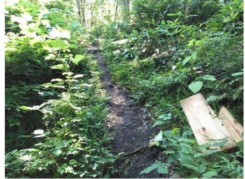
作業前の状況
