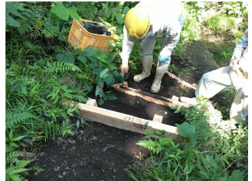
新たな木製階段の設置作業完了
