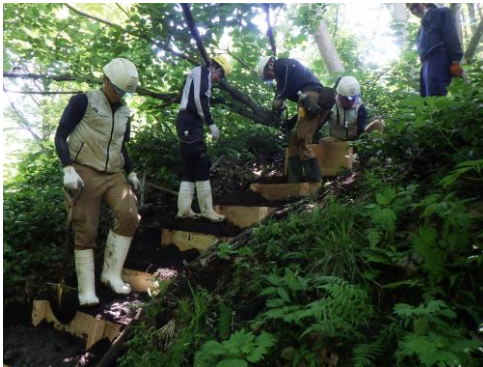
新たな木製階段の設置作業完了
