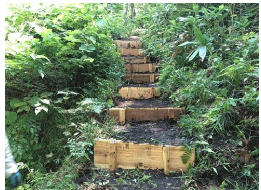
新たな木製階段の設置作業完了
