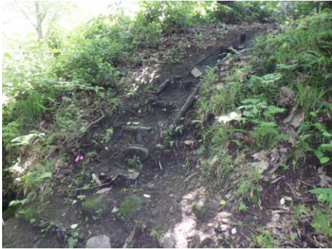
作業前の状況
