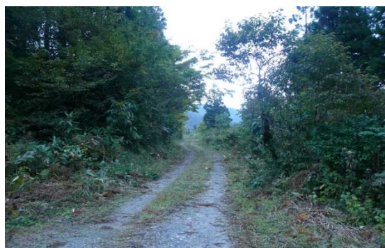
作業完了後の林道
