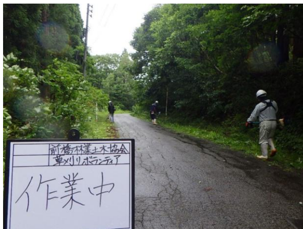
作業中の状況
