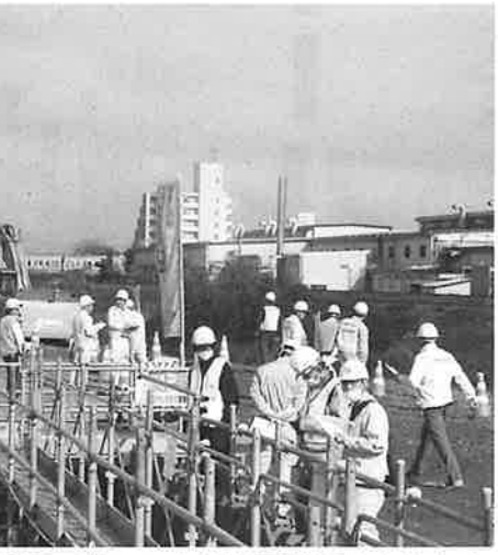
橋梁下部工の安全管理状況を点検した
